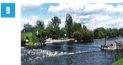
Il s'agit d'un barrage à aiguilles datant de 1841 et classé aux monuments historiques. Il est composé d'une centaine d'aiguilles en bois calées sur une structure mobile métallique. Cas unique sur le Cher, l'écluse est située à
