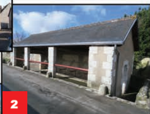
2 Lavoir de Battereau
